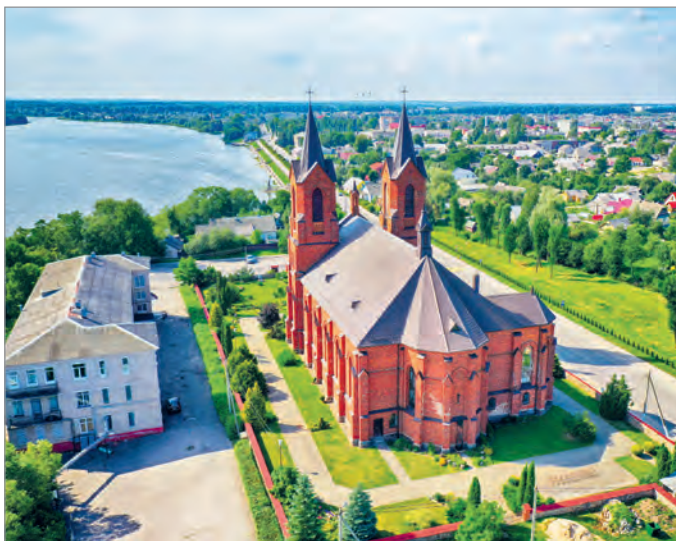
Kościół w Miorach z widokiem na jezioro
