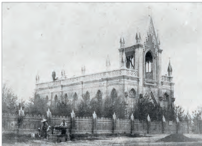
Kościół pw. św. Stanisława w Harbinie (Nowe Miasto), 3 V 1915 r. Przed ogrodzeniem studnia o głębokości 35 m
